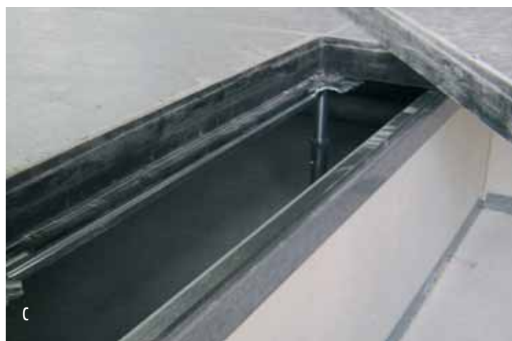
RUMORE DI CALPESTIO SENZA STRATO ISOLANTE INTERPOSTO_ Stamping sound without an interposed insulating layer_ Lärmbelastung durch Trittschlag ohne dazwischenliegende Isolierschicht_ Rumeur du piétiner sans couche isolante interposée
